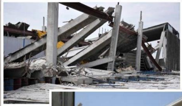
Cemento armato prefabbricato (vulnerabilità strutturali in ambito sismico)
